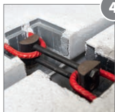
Zamek DX. System zamków trwale łączy elementy stropu ze sobą.
