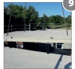
Rozpiętość XXL. Strop DX o grubości 20 cm osiąga rozpiętość ponad 7 m.
